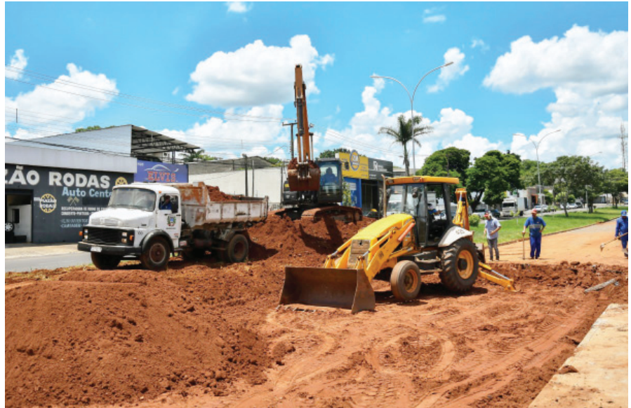
A CAPA asfáltica ainda será colocada mas o tráfego de carros e caminhões foi liberado para ajudar na compactação
