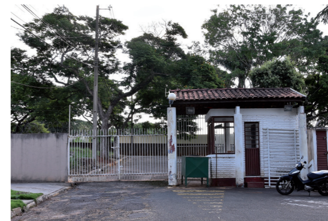
NA ENTRADA , o portão sempre fechado, dificultando entrada de estranhos
