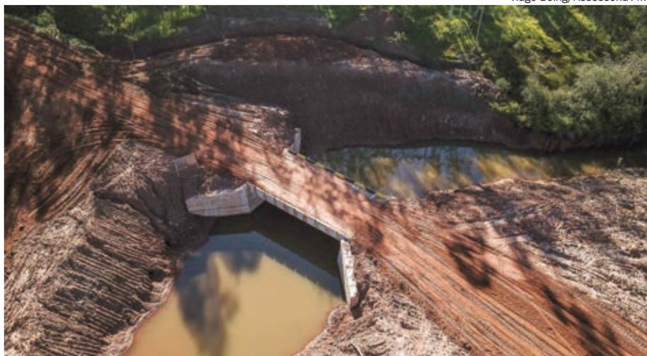
Além da construção de um canal para o escoamento, o leito da estrada foi levantado e alargado no acesso à ponte
