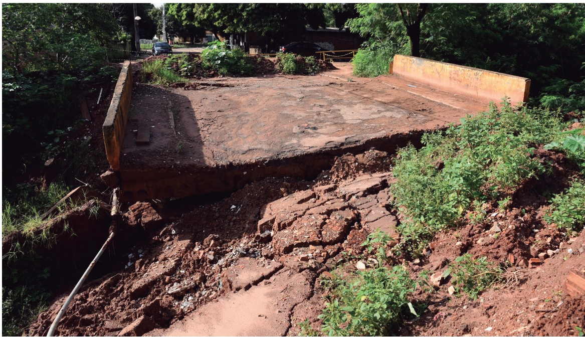
A ponte do Bairro Laranjeiras está toda comprometida
