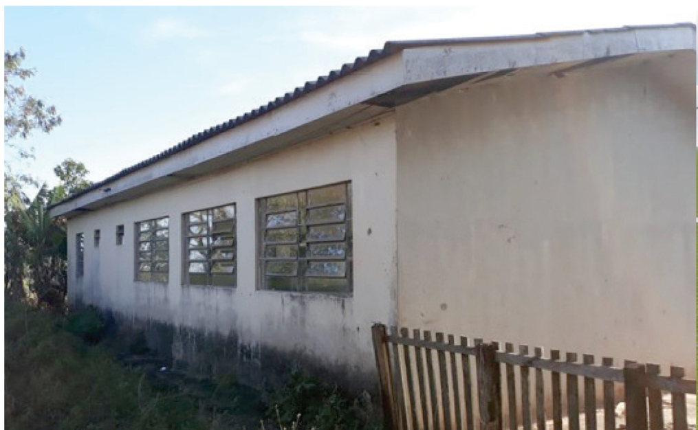
ESTRUTURA onde deverá ser instalada a Cozinha industrial antes e depois de pronta
