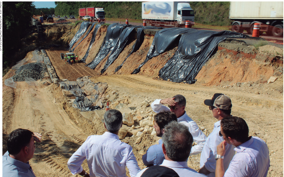
Obras em ritmo acelerado na Rodovia do Café
