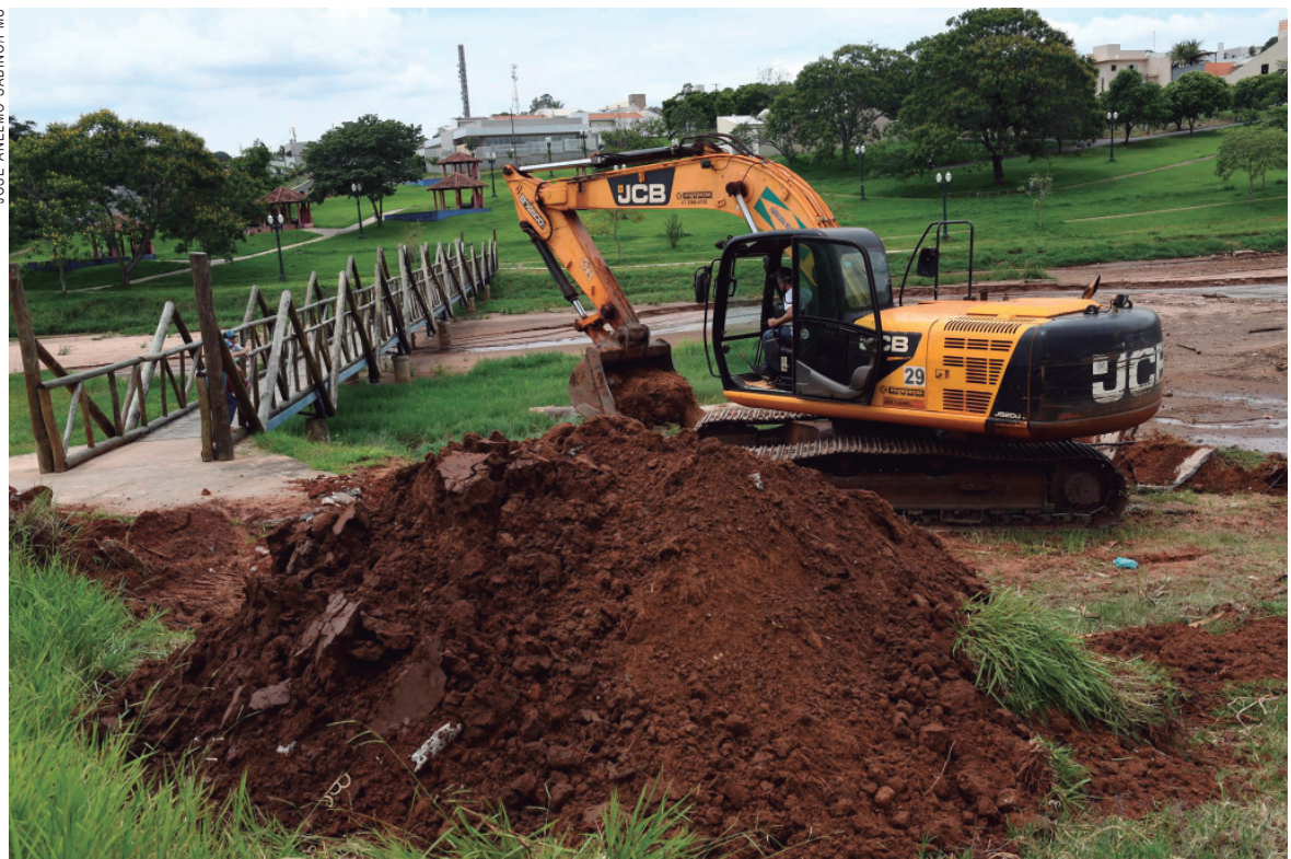
Maquina começou ontem a trabalhar no desassoreamento
