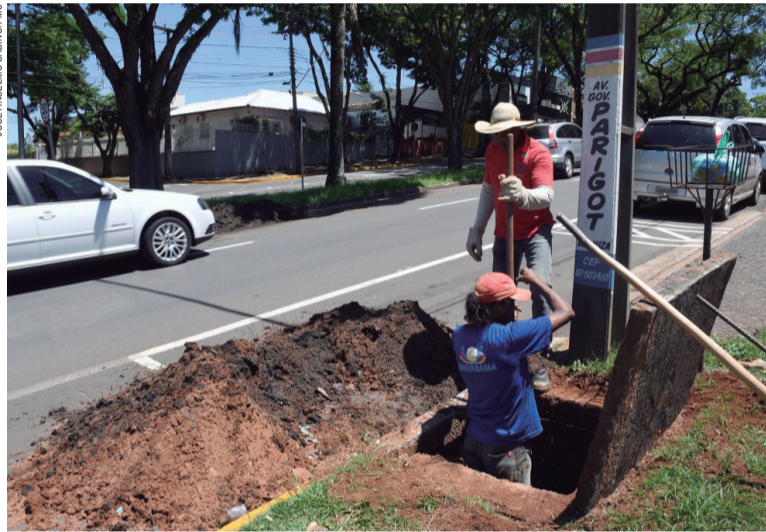
Limpeza de bueiros, um trabalho de prevenção que a Prefeitura realiza
