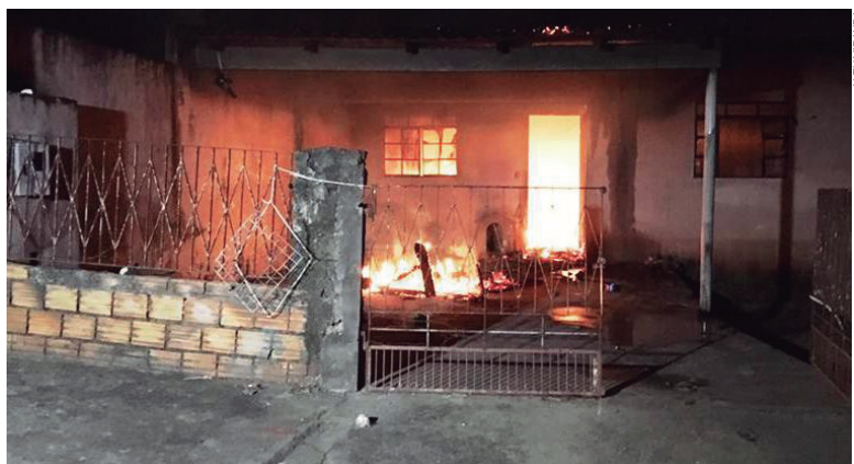
Casa foi quase que completamente destruída pelo incêndio
