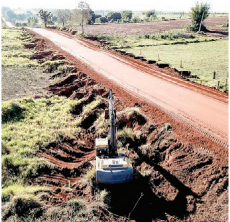
POR 7 kms, a estrada foi alargada, com microbacias e leito corrigidos e o solo compactado
