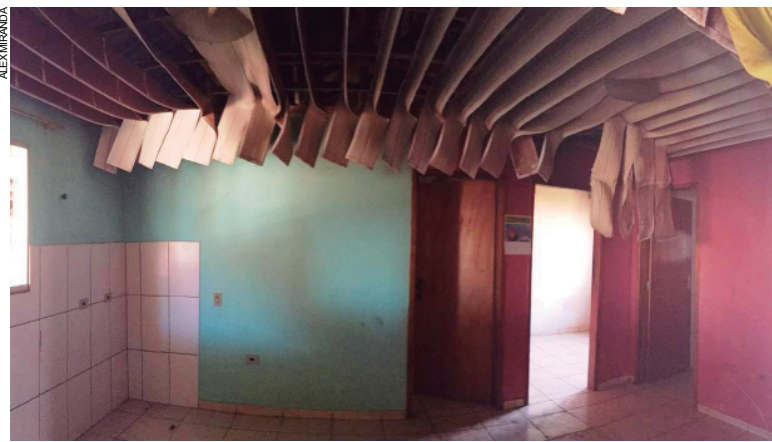
Forro de PVC derreteu com o calor do fogo que atingiu a residência no Conjunto Habitacional Sonho Meu
