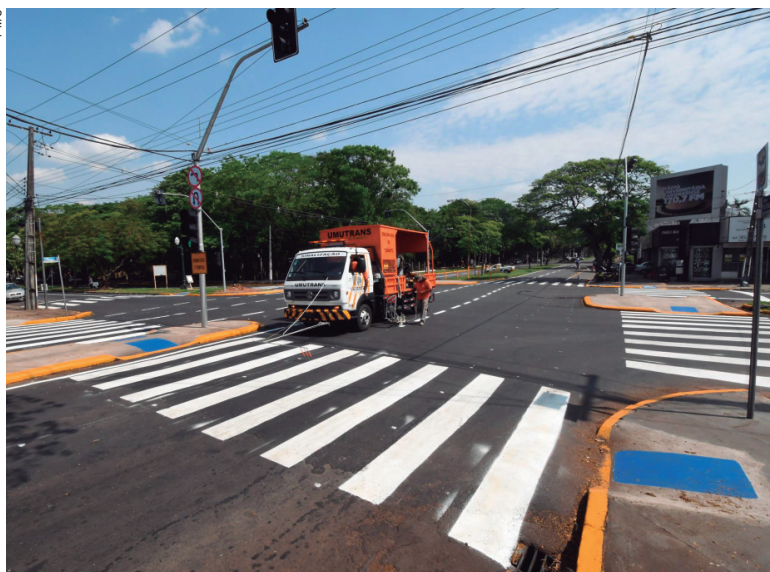
O cruzamento recebeu novo conjunto semafórico, os canteiros centrais foram alongados, além da implantação da acessibilidade e sinalização
