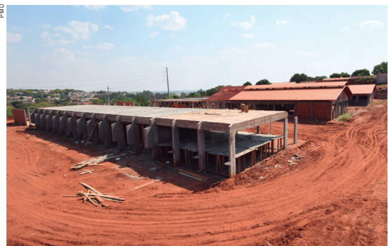
No total, a obra possui mais de 3 mil metros e está recebendo o investimento de R$ 3,6 milhões
