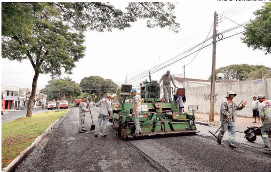
MÁQUINAS e funcionários trabalhando no trecho para recuperação da via
