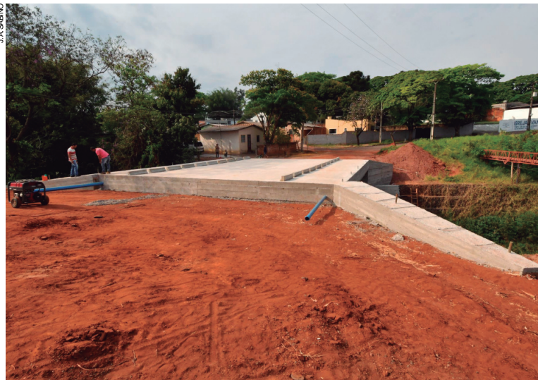
O próximo passo é aterrar os acessos à ponte nos dois sentidos
