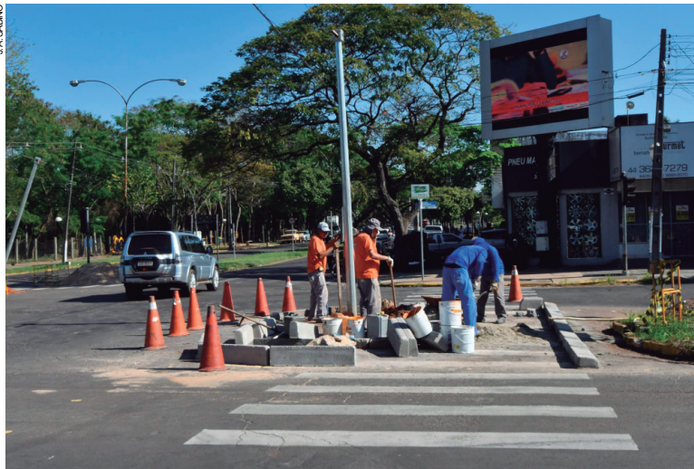
Entre os objetivos das obras está o reposicionamento do semáforos e dar mais visibilidade aos pedestres
