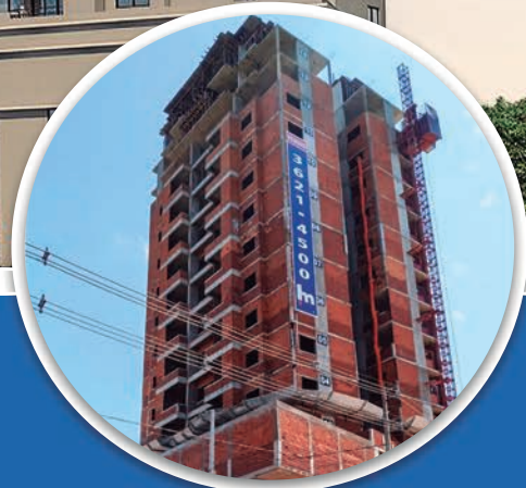
Andamento da Obra
