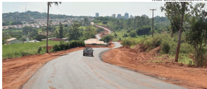
A estrada recebe 14.415 m² de pavimentação em asfalto quente em 2.400 metros de extensão, além de drenagem pluvial completa
