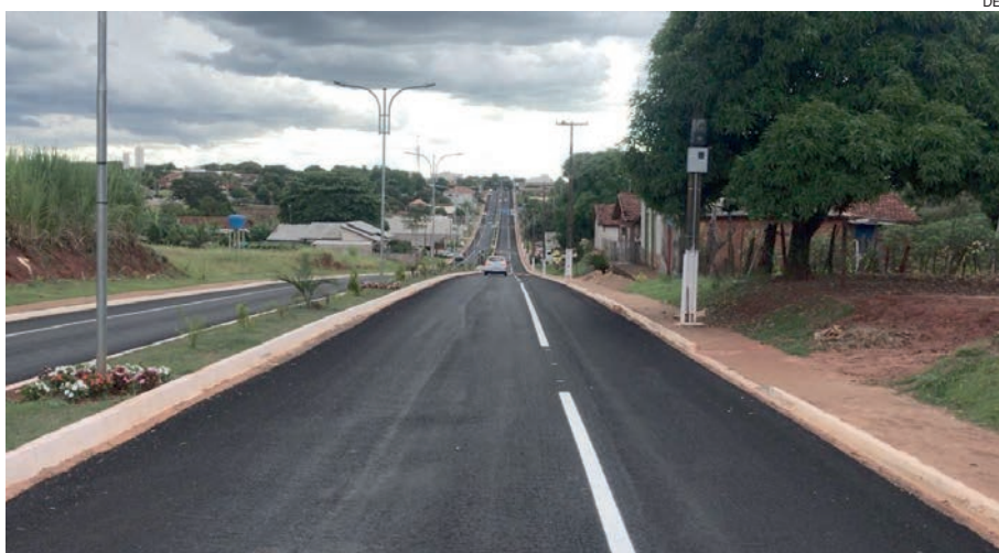
O investimento é de R$ 9,5 milhões nas obras executadas pelo DER
