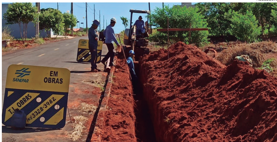
UMA das redes coletoras de esgoto está sendo implantada no Jardim Aeroporto
