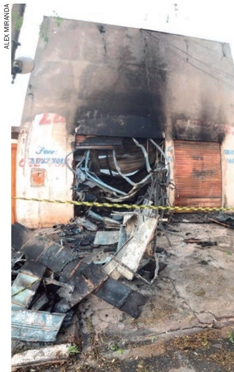
BARRACÃO ficou completamente destruído
