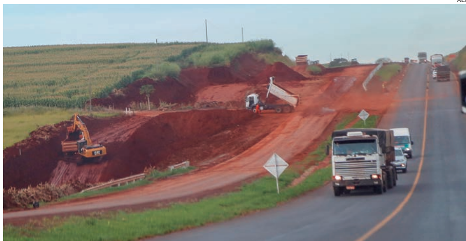
TRECHO da obra orçada em cerca de R$ 55 milhões, fica entre Doutor Camargo e a futura variante do Rio Ivaí, no Noroeste
