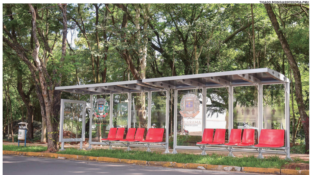
ESTRUTURA dos novos pontos são de tubos galvanizados, com fechamento em vidro temperado, com espaço publicitário e identificados com o brasão do município
