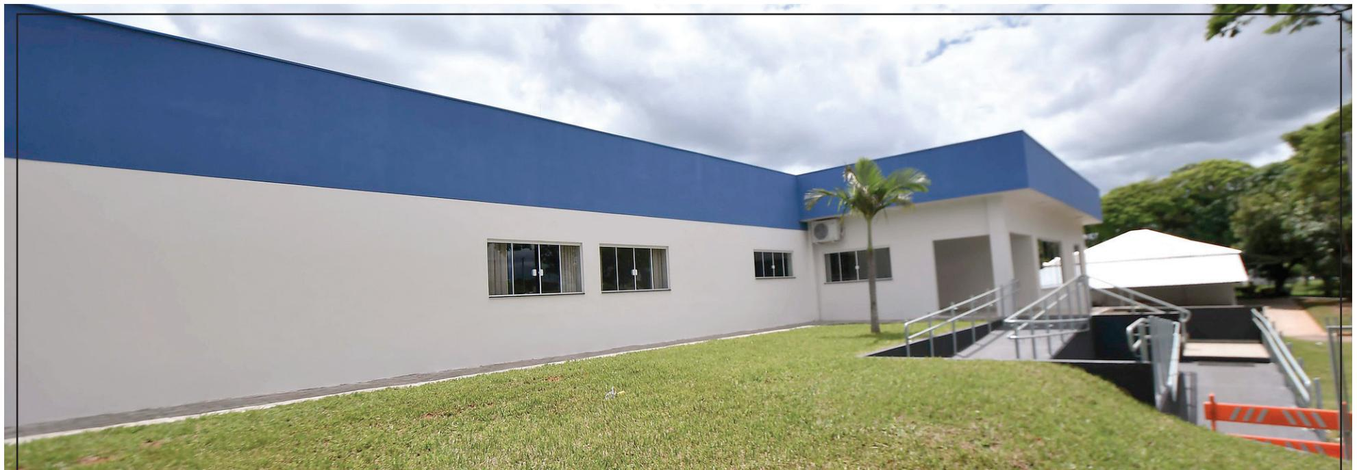
Prédio onde funcionam a Secretaria de Defesa Social e a Umutrans passou por reforma completa e revitalização, ganhando 133 m<sup>2</sup> de área construída em alvenaria e 110 metros de cobertura metálica aberta, totalizando 244 m<sup>2</sup> de ampliação. **| 5**
