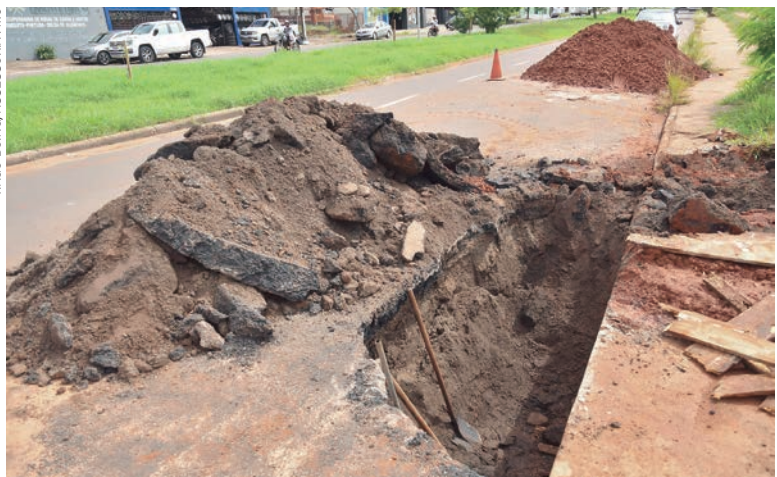
O local está sendo constantemente monitorado, porém no momento não pode passar por reparos definitivos
