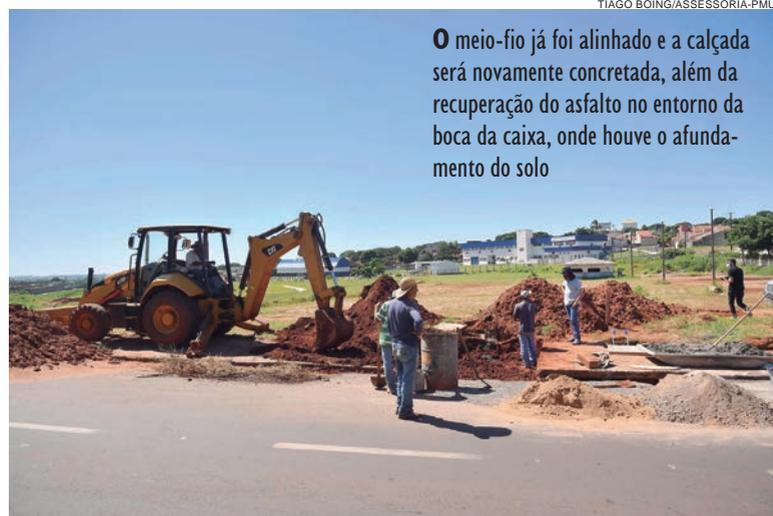
O meio-fio já foi alinhado e a calçada será novamente concretada, além da recuperação do asfalto no entorno da boca da caixa, onde houve o afundamento do solo
