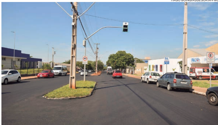
O último trecho recebeu a capa de massa asfáltica quente ontem. A via também teve ampliação da rede de galerias pluviais nos dois sentidos
