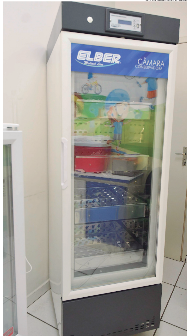
ENTRE as 23 unidades básicas de saúde, 22 possuem geladeiras para armazenagem de vacinas com temperatura controlada, variando entre 2 a 8 graus
