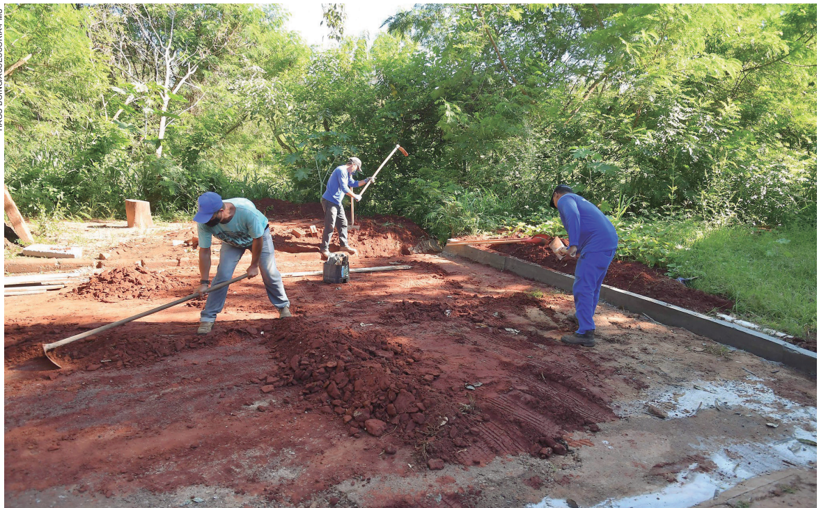
DESDE o início do ano são realizados trabalhos para recuperar estragos causados pelas chuvas em ruas e bairros da cidade
