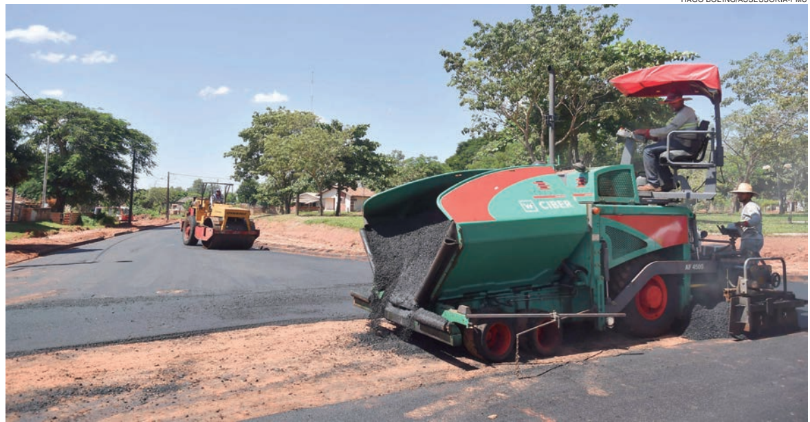
O investimento é de mais de R$ 960 mil na construção de mais de 7 mil m 2 de asfalto em CBUQ, galerias pluviais e bocas de lobo
