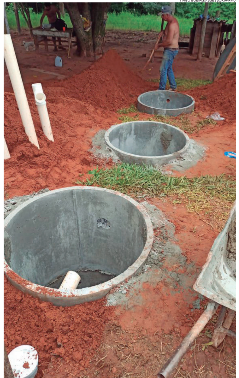
DIRETORIA de Meio Ambiente contratou empresa para a construção de fossas num sistema que ajuda a evitar a contaminação do solo com o despejo de resíduos
