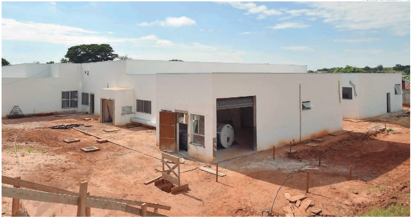
INICIADA em 2018, a obra está com mais de 80% executados, em fase de acabamento, restando apenas a pintura, conclusão dos muros e o ajardinamento
