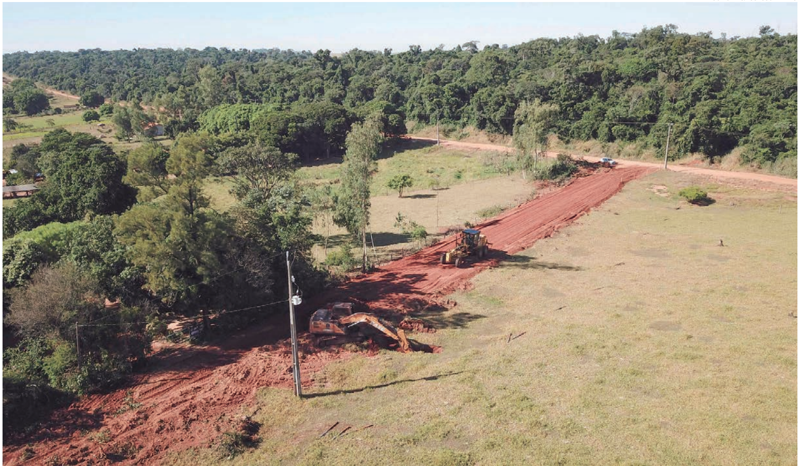
SERÃO alargadas as passagens, levantado o leito e reforçada a compactação nos trechos mais íngremes
