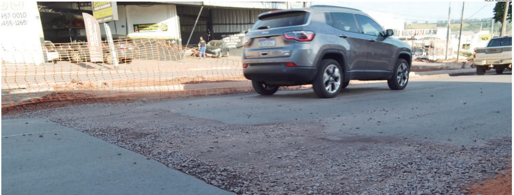
A recomposição asfáltica deverá ser no mesmo nível da capa existente, não sendo toleradas lombadas com a previsão de que haverá compactação posterior pelo tráfego
