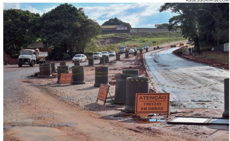
A maior parte do trecho já foi pavimentada, além da construção de muro de arrimo, galerias pluviais e iluminação em LED
