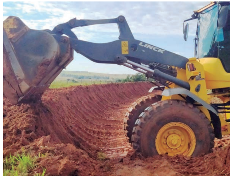
O trabalho, em parceria com Instituto de Desenvolvimento Rural do Paraná, é de controle de erosão, terraceamento e cercamento da APP
