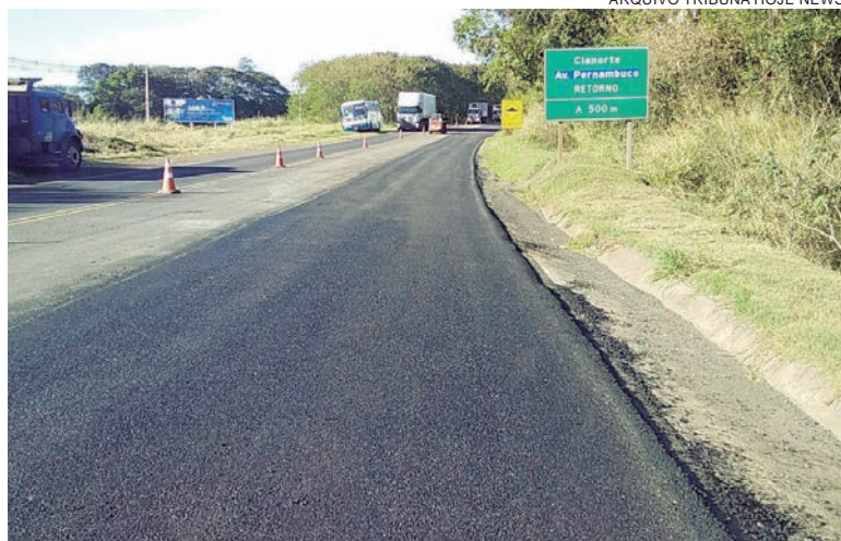
Trechos da rodovia PR-323 entre os municípios de Cianorte e Maringá, fazem parte da área onde serão aplicados parte dos recursos
