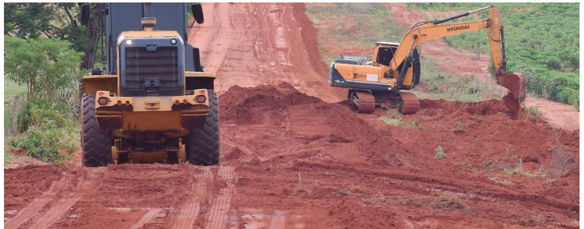
O trabalho na estrada João Baraniuk, entre a Estrada Coronel e Vila Nova Jerusalém depende das condições climáticas para ser encerrado nos próximos dias
