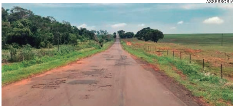
PISTA entre os municípios de Nova Olímpia e Cruzeiro do Oeste está repleta de falhas no asfalto e buracos que podem causar acidentes graves
