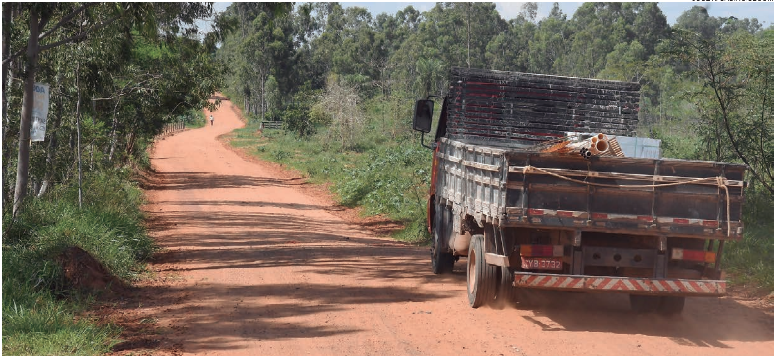
A Estrada tem 3.320 metros de extensão (21.424,94 m 2 além de galerias pluviais e bocas de lobo), partindo da rodovia PR-580, dentro da APA do Rio Piava
