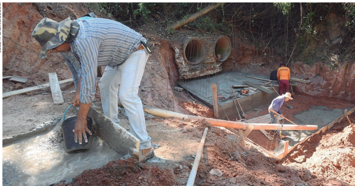
O trabalho é executado por uma empresa terceirizada, que presta serviços de manutenção e implantação de drenagem pluvial ao município
