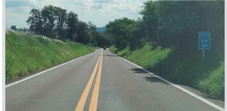
ENTRE Tuneiras do Oeste e Moreira Sales, um trecho de 28,16 km da PR-479 recebeu nova sinalização horizontal, com linha dupla contínua e linhas de bordo em toda extensão
