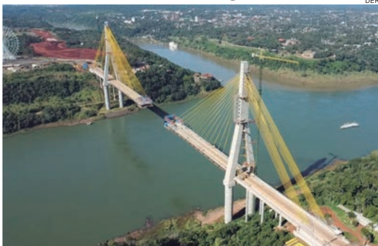
FALTAM 76 metros para a conclusão da ponte que tem 760 metros de comprimento, com duas pistas simples de 3,6 metros de largura, acostamento e calçada
