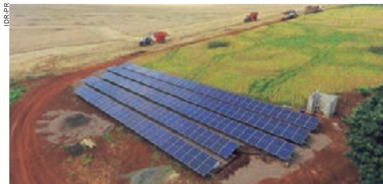
O RenovaPR está aberto aos produtores interessados tanto na instalação de unidades solar fotovoltaicas quanto de biodigestores, que transformam a biomassa em energia
