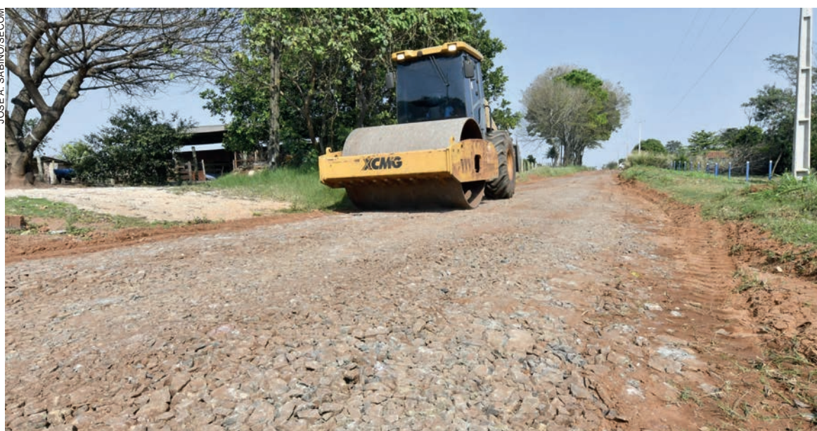
A intenção é estruturar a via para que o tráfego esteja assegurado mesmo em períodos chuvosos, já que a estrada não é pavimentada
