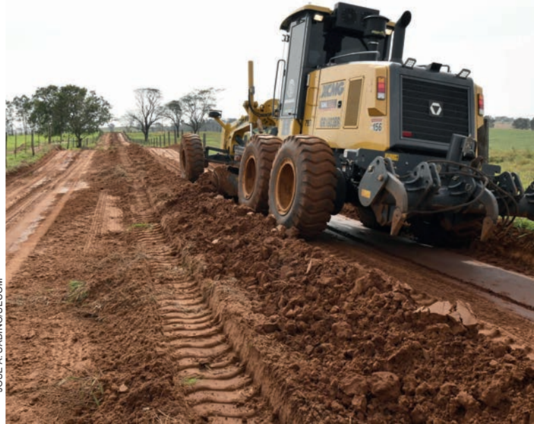
Equipes estão mobilizadas no trecho de aproximadamente 2 kms que começa na PR-323 e divide os municípios de Umuarama e Perobal
