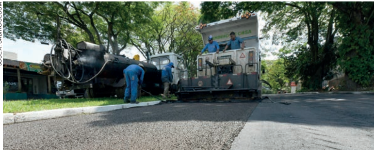
A capa de micro sela o pavimento evita que a umidade se infiltre para o solo e reduz o risco de surgirem trincas e buracos no asfalto
