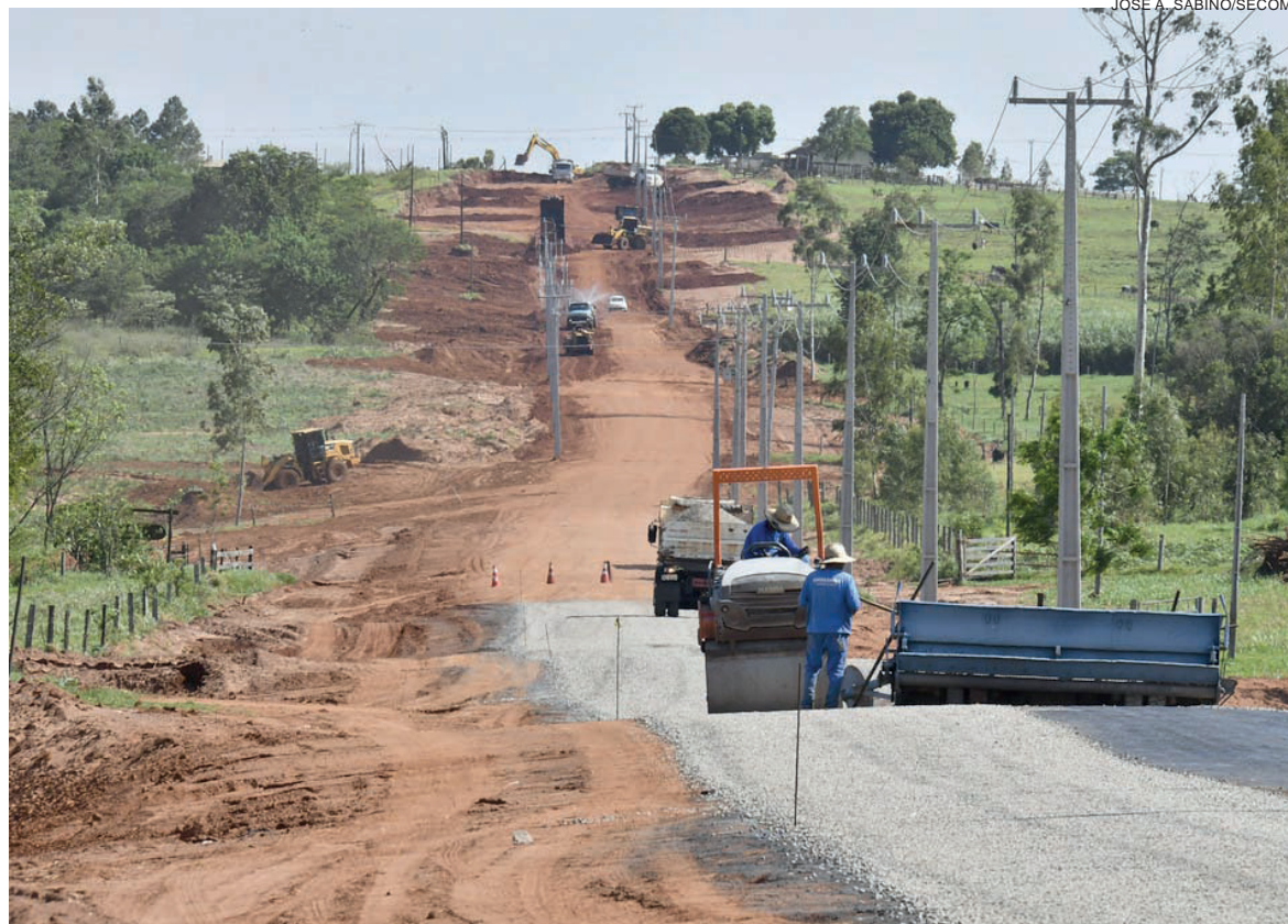
Pouco mais de dois quilômetros já recebeu o asfalto e o trecho restante está na fase de preparo, com adequação de leito e solo-cimento
