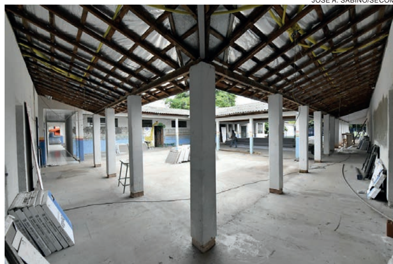
Do total de R$ 1.221.870,13 previstos em investimentos nessa obra, em torno de R$ 450 mil já foram executados
