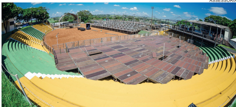
Nova passarela para cantores e espaço elevado para animais são destaques na 50ª edição da feira
