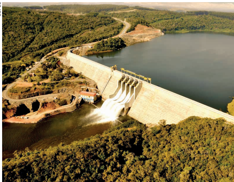
COPEL detém a concessão de 887 km de linhas de transmissão de energia e uma subestação de grande porte em São Paulo
