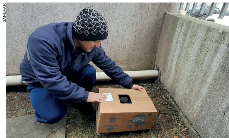
Com o objetivo de evitar o congelamento da água na tubulação, a proteção pode ser feita com uso de caixa de papelão, plástico, lona ou madeira
